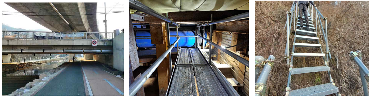
<현수관로> <지하철 공시장 노출관로> <배수지 경사면>
