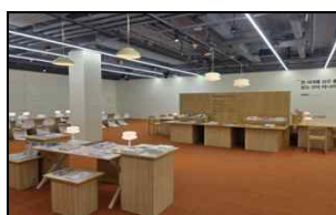
<디자인랩 3층 리뉴얼 공사>
