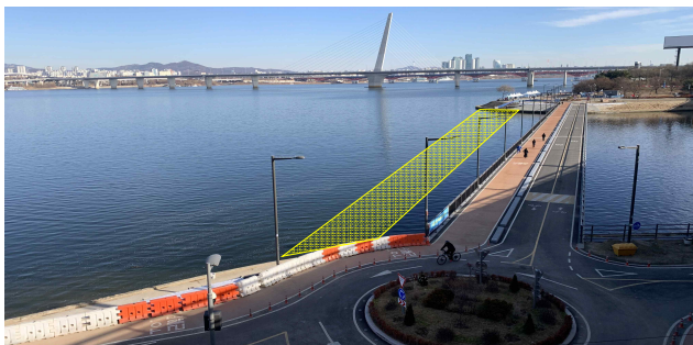
<교량 신설 및 노후 교량 철거>
