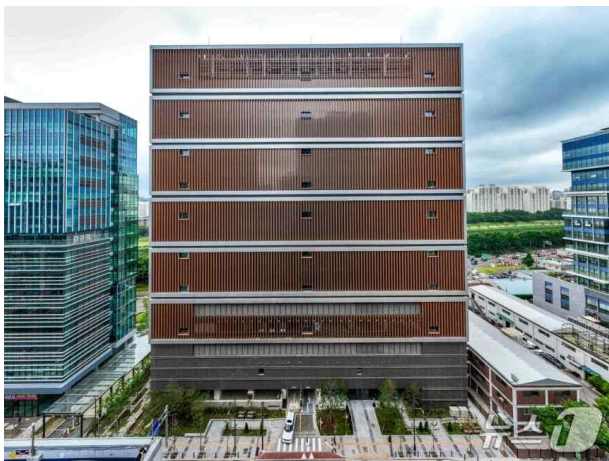
[금천구 가산동 데이터센터 전경] 출처: 뉴스1(2025.11.6.)기사 9)
