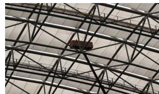
〈철골 용접 및 도장〉
