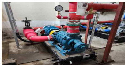
<터널 노후 소방펌프 교체>
