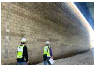
〈옹벽 시설 점검사진〉
