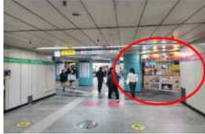
<잠실역 상가 철거>
