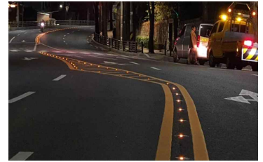
<도로표지병 병행 설치>
