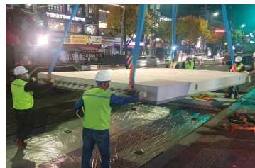
<현장 조립 시공 >
