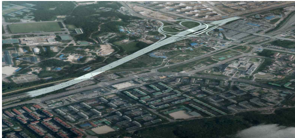
<태릉~구리IC간 도로확장 공사> 조감도
