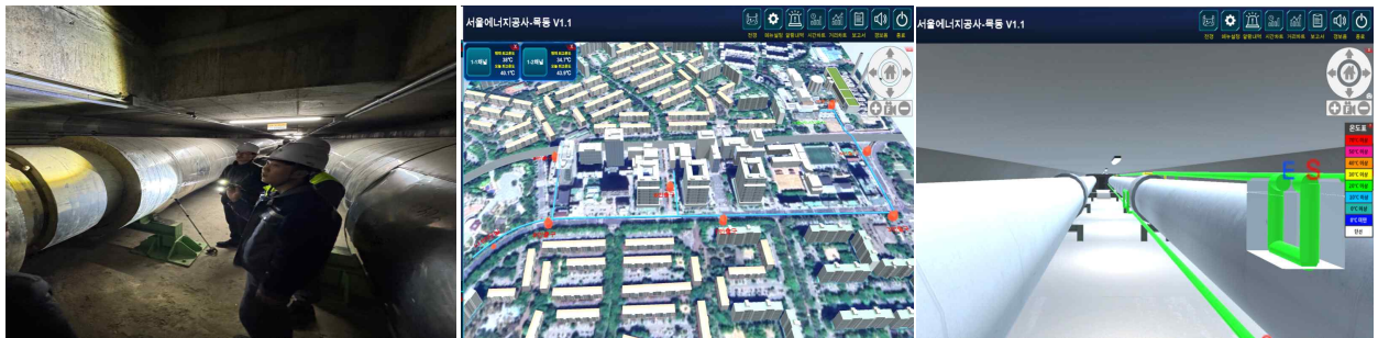
< 공동구 열수송관 점검 >
