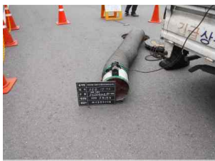
밀폐공간 사전작업 (산소농도측정, 환기)
