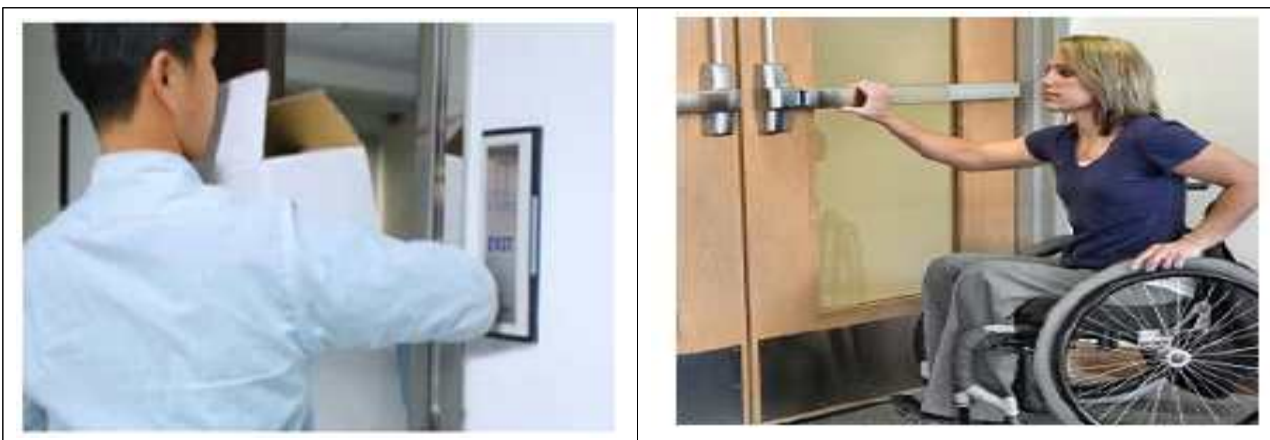
[그림-1] 출입구 버튼 및 손잡이에 유니버설디자인을 적용한 사례
