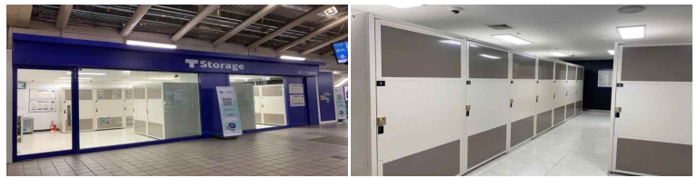
[답십리역 생활물류센터 조성 후]
