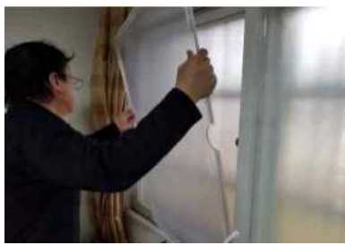
〈단열 향상 위한 덧유리 시공 사례〉
