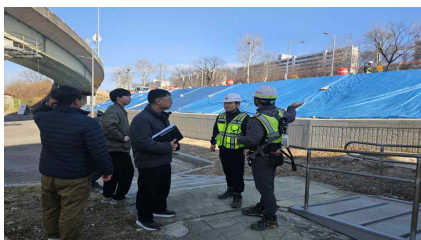
< 공사장 점검(잠실대교 남단IC연결체계 개선)>
