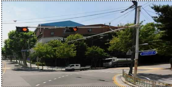
동작구 대방동 대방주공아파트 앞 노후지주 교체 전
