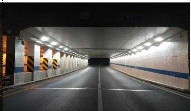
노원구 월계2지하차도 등기구 교체(LED) 후
