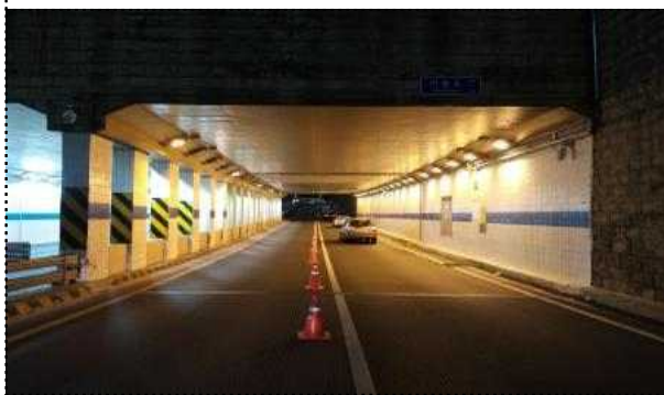
노원구 월계2지하차도 등기구 교체(나트륨) 전
