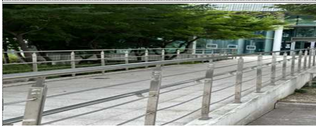
물과환경전시관 정문 안전난간
