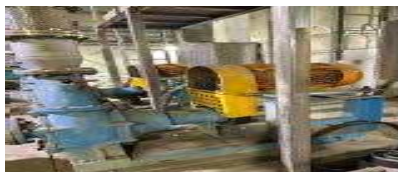
모터펌프 방호덮개 설치
