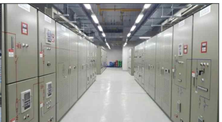
전기실 수배전반 공사
