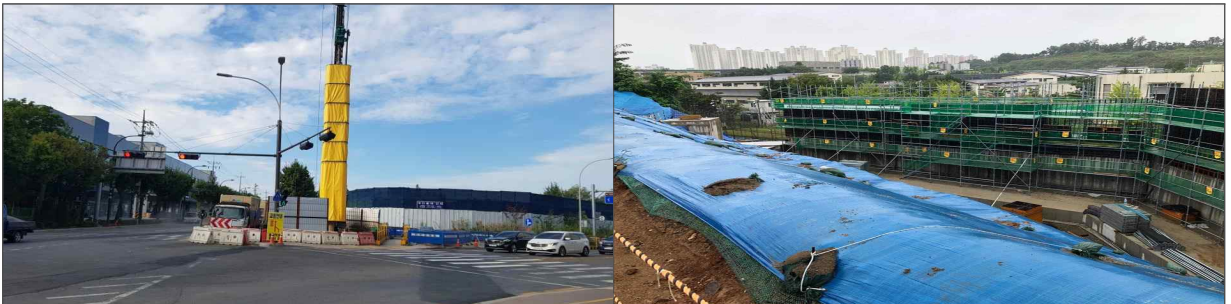
본선 개착(선사초교사거리, 파일천공 및 근입)
