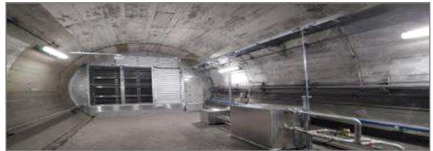
< 양방향 집진기 설치 >
