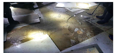
【바닥패널 보수 공사】
