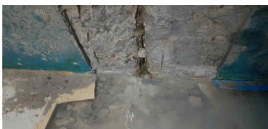
【신축이음 보수 공사】
