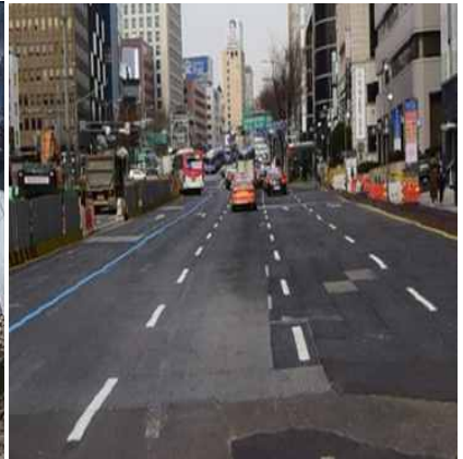
[신분당선 지하철 공사장]
