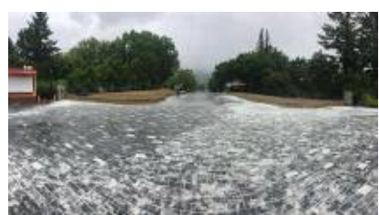
공사 중 전경사진
