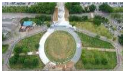
공사 중 전경사진
