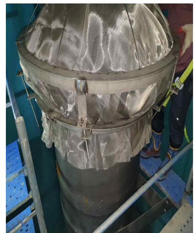
【배수지 거름망 설치】
