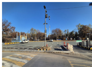
강서 주차장 확장 전·후
