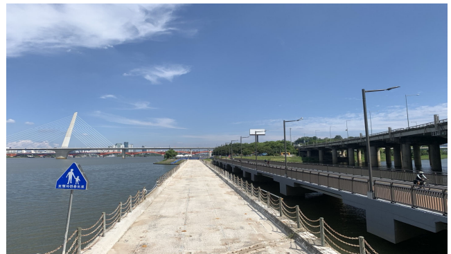
철거 예정 교량
