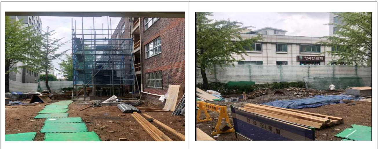
[그림-2] 샌드위치 패널 건물 철거 현장
