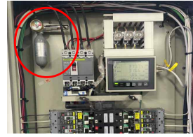
[소공간 소화장치 설치]
