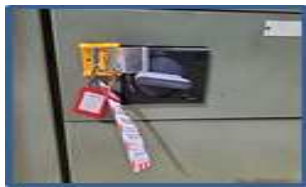
< MCC 판넬 설치 >
