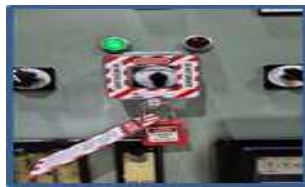
< 푸시버튼 스위치 설치 >
