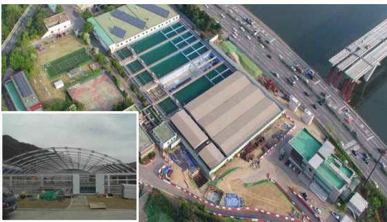
【침전지 상부 기존 임시덮개(3개지)】
