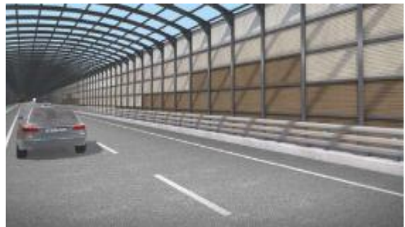
【정수센터 경유 상부도로 방호터널 설치】
