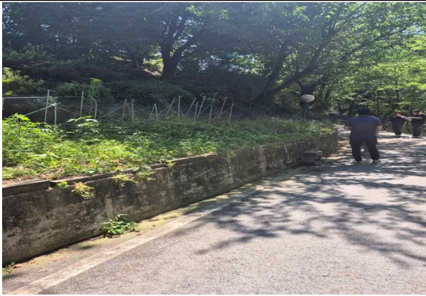
기존 옹벽 공사 전
