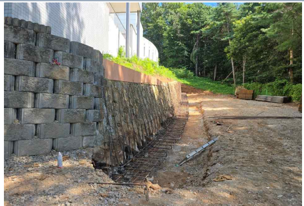
콘크리트 타설 전 철근 배근 작업
