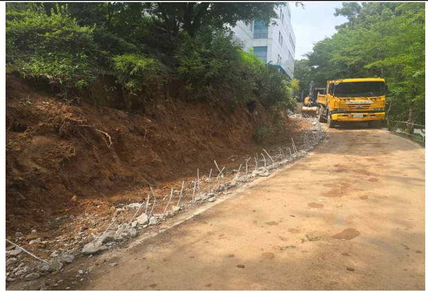
기존 옹벽 철거
