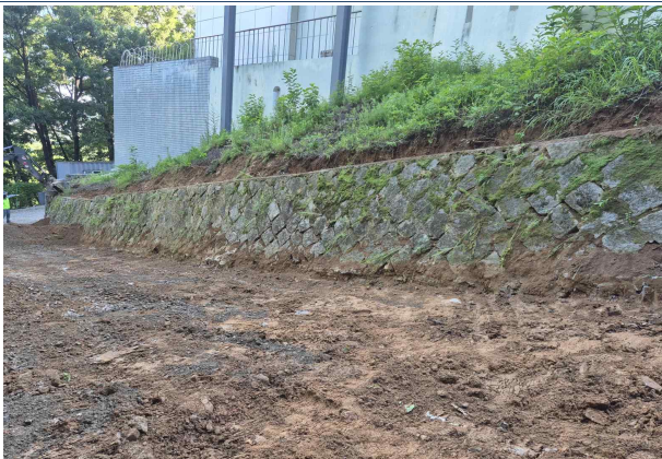
기존 옹벽 보수 공사 전 바닥 작업
