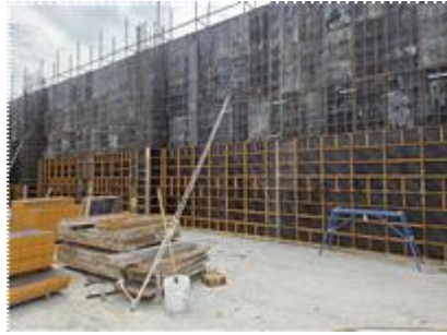
<벽체 형틀 설치>
