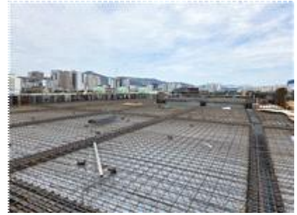
<바닥 데크플레이트 설치>
