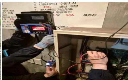
<분전반 절연저항 측정>
