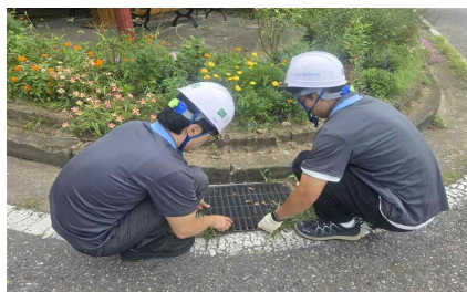
<배수로 망 설치>
