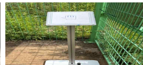
<인체 접지 스테이션 설치>
