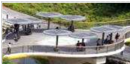
강북구 보도교량 태양광 쉼터
