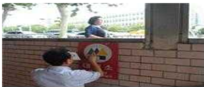
<민방위 대피시설 점검>
