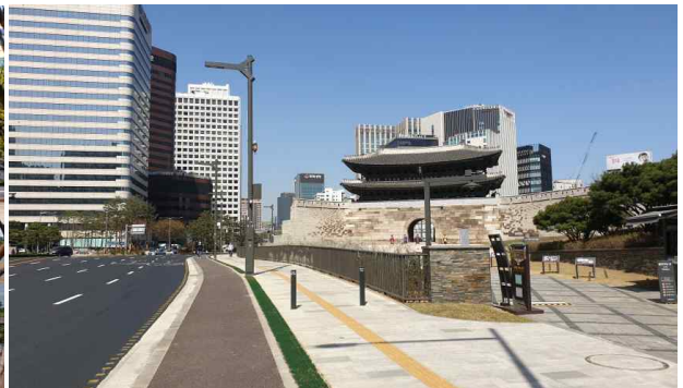
【송례문구간 보도 및 자전거도로 신설】
