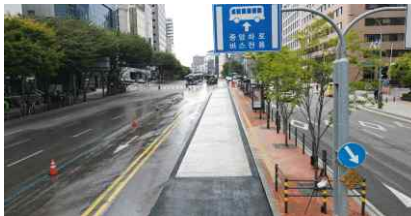
고강성 콘크리트 포장
