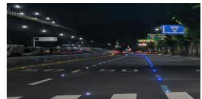
도로표지병 병행 설치
