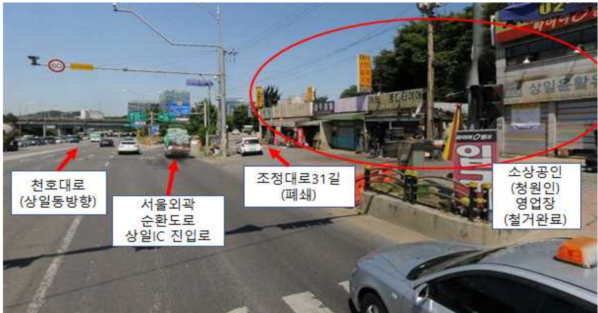
<천호대로 및 조정대로31길(폐쇄 전), 소상공인 영업장(철거 전) 현장사진>
