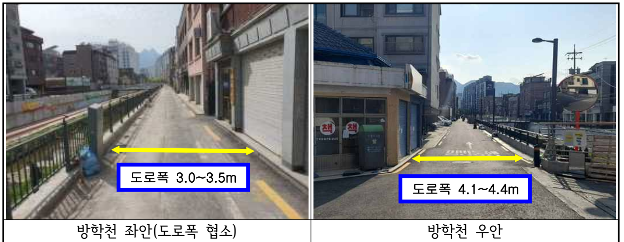
[그림 2] 방학천(도봉구) 위험 옹벽 보강공사 현장 사진
