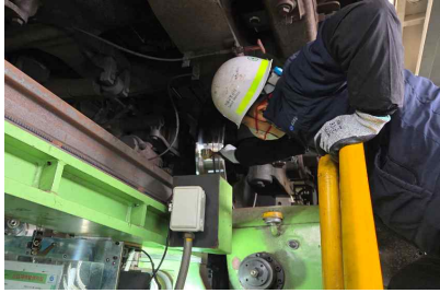
〈회전체 작업 사진〉
