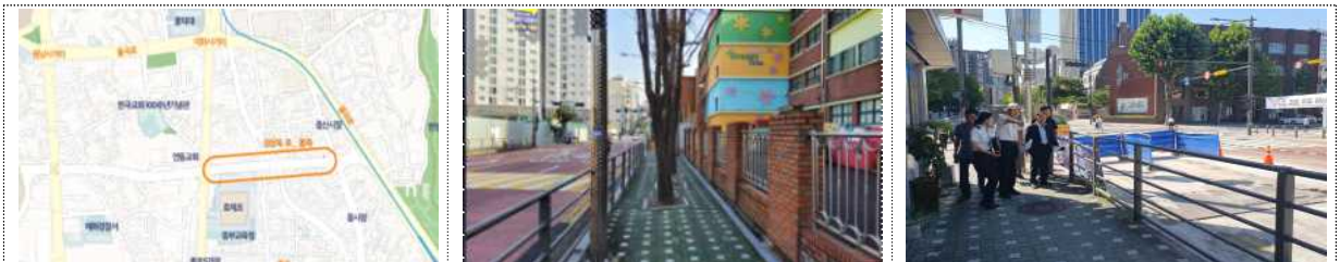
효제초교 보행로 지장물 현황 및 공사현장 점검
