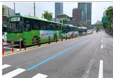
무단횡단 금지시설 설치
