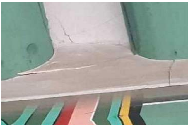
자정전 회랑 당골 보수공사 전
