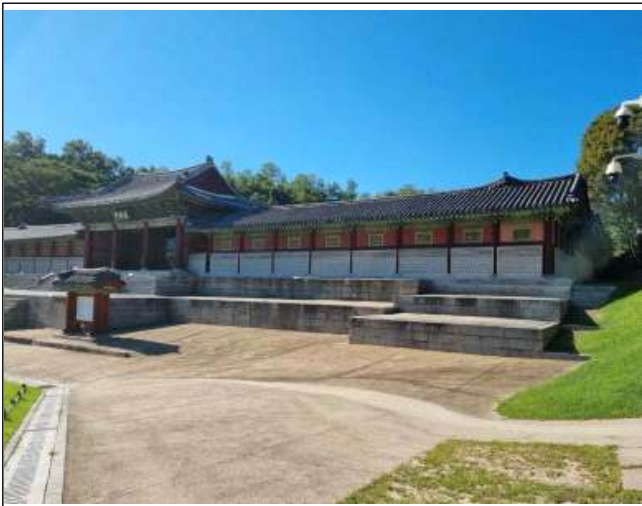
송정문 데크 공사 전
