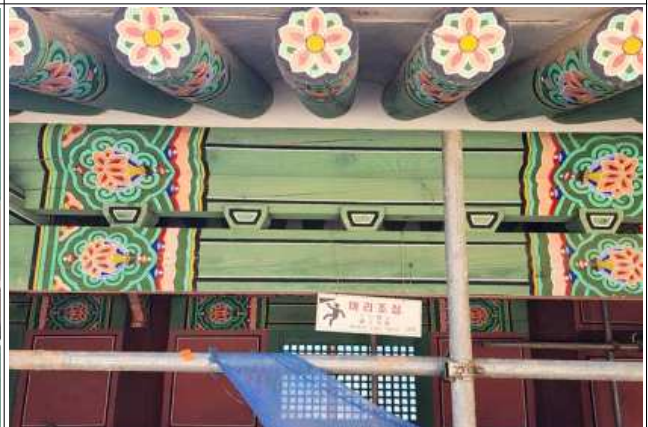
자정전 회랑 당골 보수공사 후
