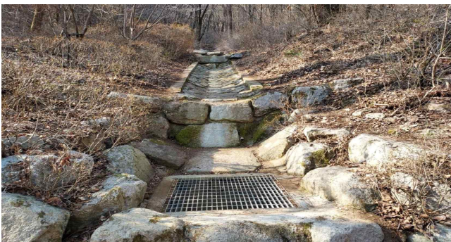
< 해빙기 안전점검 배수로 청소 >
