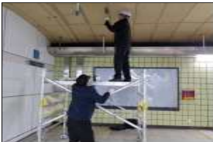
천정형 피난유도등 보수작업
