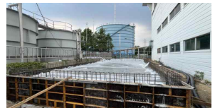
< 악취방지시설 기초 타설 >
