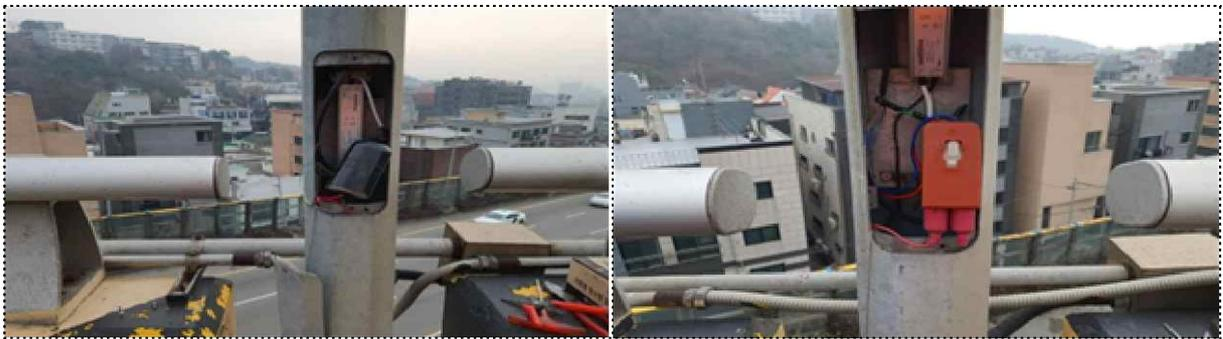
[설치 전] 용산구 남산소월고가차도 가로등 방수형 누전차단기 [설치 후]
