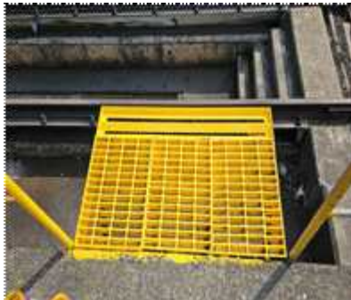
【보조발판 도색작업 후】
