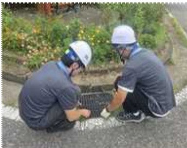
【배수로 망 설치】
