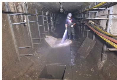
〈월계지하차도 공동구 정비〉
