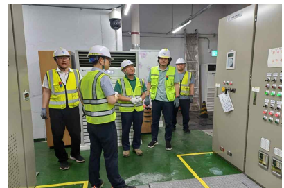
〈서부트랙터미널앞지하차도 배수전반 점검〉
