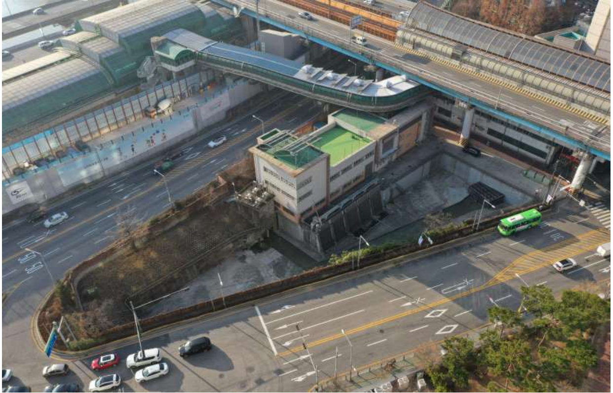
< 옥수유수지 공영주차장 조성 전 현황 >
