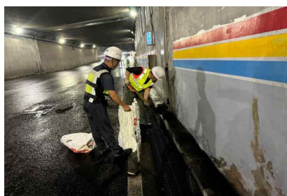
〈가마산지하차도 배수로 정비〉
