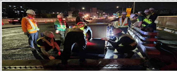
<교량 방수공법 점검>
