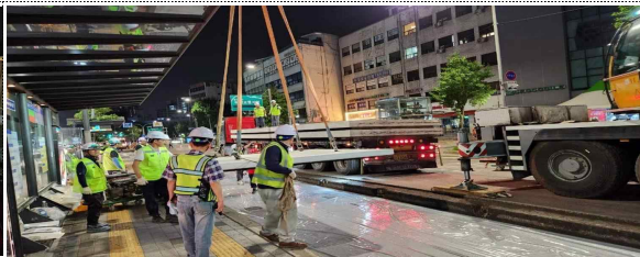
<고강성 콘크리트포장 점검>
