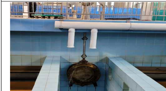
[ 활성탄 흡착지 내부 설치 전 ]
