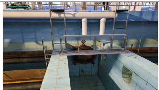
[ 활성탄 흡착지 내부 설치 완료 ]
