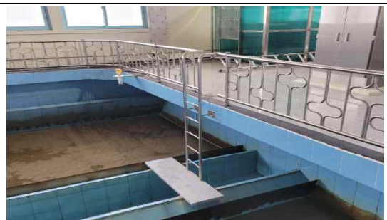
[ 여과지 내부 설치 완료 ]
