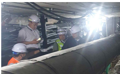
< 공동구 열수송관 점검 >
