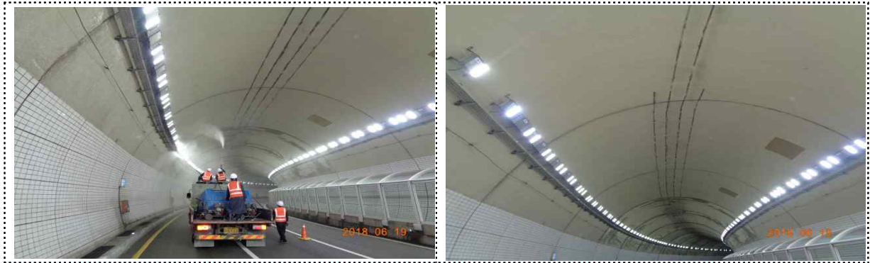
〈 강남구 일원동 일원터널 도로시설물 세척작업 〉
